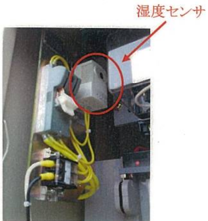
赤相ヒータ外観 ○KSW「切」位置が湿度センサによる自動運転 ○200[V]、30[W]、70[%]自動運転(74%で入、66%で切)
